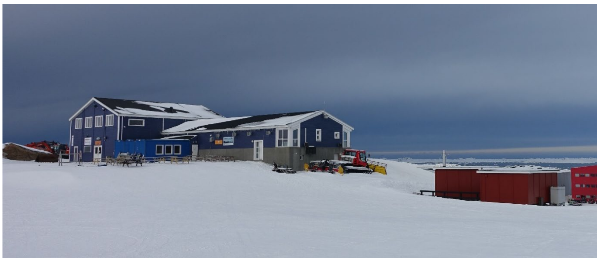
Figur 10 – Bygning til drift af skilift t.v. og bygning med formål til kiosk t.h.
