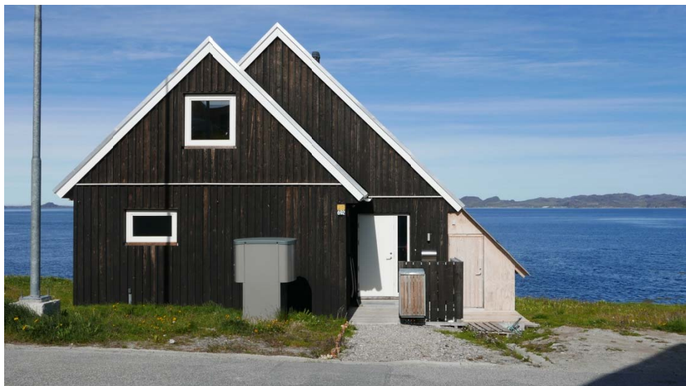
Fig 10: B-692 Ilasatut assersuutissaqqippoq, ileqquusutut illuliaanermigut illup sananeqaqqaarnera ataqqillugu suliaq (type 16), taamaakkaluartorli ersarissumik ilasaanera takuneqarsinnaalluni. Taanna assersuutissaqqissuuvoq piffissami illulortaatsimut naleqqummat.
