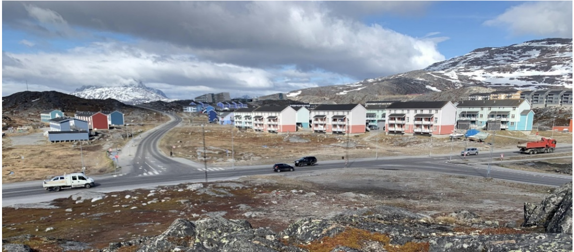
Set ud over arealet hvor rundkørsel skal etableres ud for Nuussuaq vejen.
