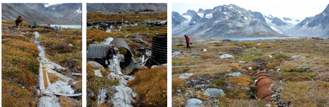
Fig. 15. Brudte og rustende vandrør ved Ikkatteq-BE2. Et komplekst grøfte- og nedgravet afløbsrørsystem bidrog til at lede smeltevand og forhindre, at de nedre områder af lejren blev oversvømmet i løbet af foråret (fotos: H. Lange, 2018).
