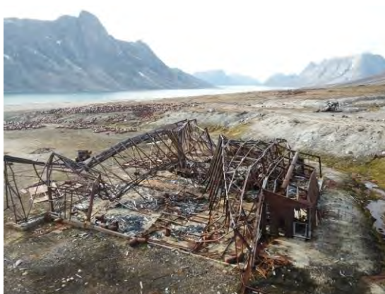
Fig. 8. Hangaren af stål er den eneste "stående" bygningskonstruktion tilbage på Ikkatteq-BE2 og den største bygningsrest. (foto: H. Harmsen 2018).
