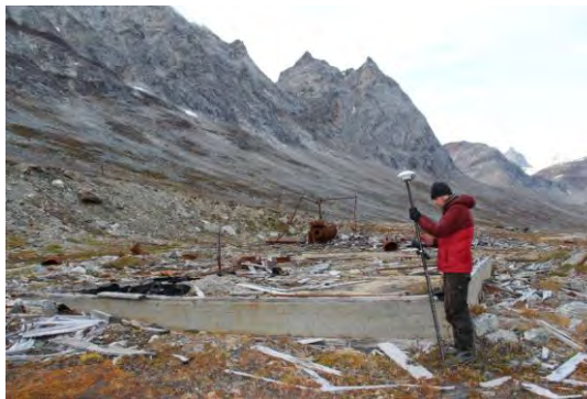
Fig. 10. Der findes flere betonfundamenter fra bygninger ved Ikkatteq-BE2 (foto: H. Lange 2018).
