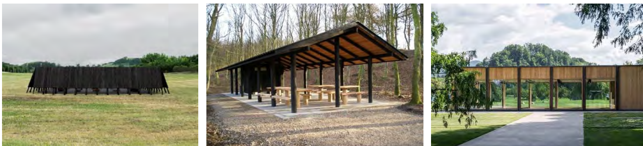
Fig 43. Eksempel på informations-/madpakkehus ved Ikkatteq-BE2
